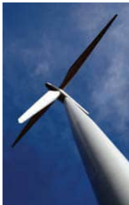
STORE FORHOLD: Rotordiameteren på vindmøller i store Norske vindparker er på over 80 meter og hver vingveier veier ni tonn. Rotorvingene fanger vinden og overfører kraften via drivakselen til en generator i maskinhuset.
