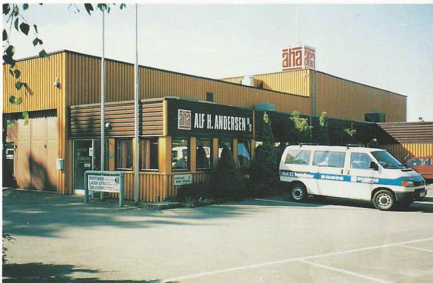
Forretningsbygget til Alf H. Andersen A/S ligger pent i terrenget på Breili i Sandefjord med grunnflate 1200 kvm, fordelt på to etasjer. Tavleverkstedet belegger ca. 300 kvm. Bygget leies ut til bedriften av tidligere eier.
