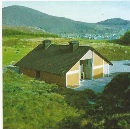
Dette er — enten man tror det eller ikke — en transformatorstasjon, utviklet og produsert av Siemens i Trondheim. Dette nye tilbud til landets elektrisitetsverker reduserer dimensjonene på transformatorstasjonene betydelig, og markerer seg på en annen og mer miljøvennlig måte i landskapet. Stasjonen tilhører Søre Sunnmøre Kraftlag og er ganske nylig satt i drift.
