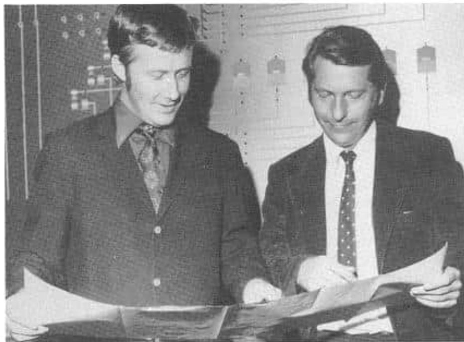
Jarle Øyum (t.v.) er ansvarlig for anlegget på AKA og Olaf Baardsgård er prosjektleder. Her diskuteres det foran den sentrale styretavlen i meieriet. 700 ventiler dirigeres herfra.
