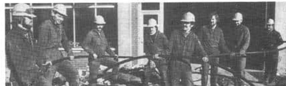
Her ser vi Siemensmontører med en gjenstridig kabel. Det er til sammen strukket ca. 100.000 meter kabel på anlegget. Siemens står for samtlige elektriske installasjoner ved meieriet. Foruten kabelstrekking består leveransen av effekt-transformator, høyspent anlegg, lavspente fordelinger, belysning innen- og utendørs, telefonanlegg og et fjernstyringsanlegg for prosessen. Dette representerer en omsetning på ca. 10 mill. kr.
