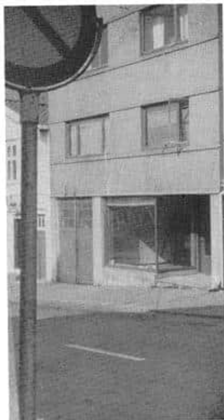
Det nye Siemenskontoret holder til i Thuhaug-gaten nr. 4. Bildet ble tatt før innflyttingen og malere har vært i sving siden den gang.
