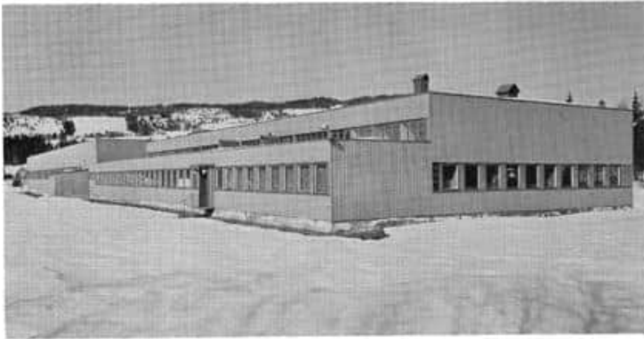
På bildet ser vi industribygget som Siemens nå skal leie på Tomra i Selbu, ca. 6 mil øst for Trondheim. For tiden står lokalene tomme, men allerede for sommerferien regner man med at Siemens kan starte opp produksjon - hovedsakelig del- og spesialproduksjon for Elektrovarmefabrikken.
