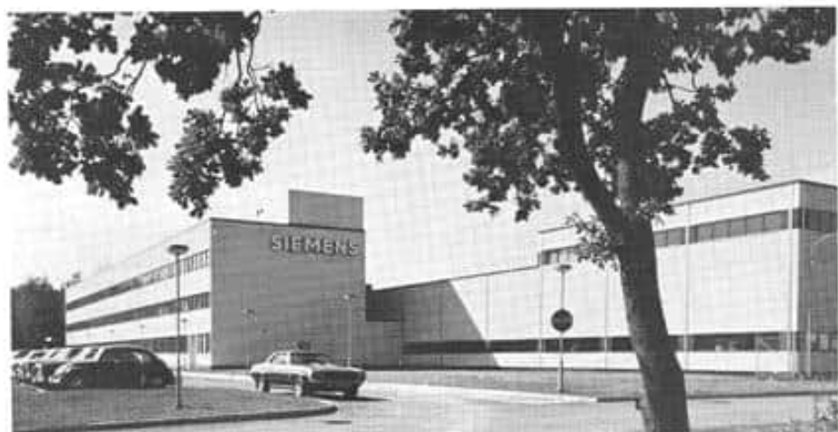
Eskilstuna Fabrikken (EFAB) produserer lysarmaturer for alle Siemens-selskapene i Norden.
