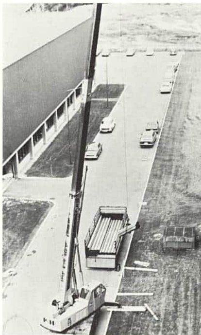
— Byens største mobile kran er mobilisert for å bringe materialene vindusveien inn i 6. og 7. etasje på Linderud. Det blir luftige svev.
