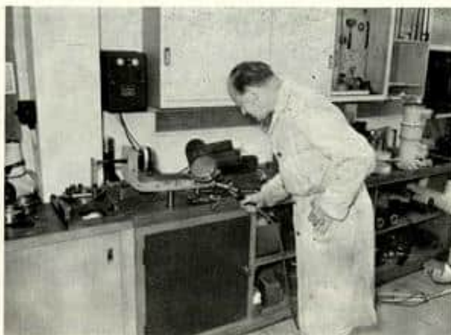
Stokka reparerer røntgenrør.
