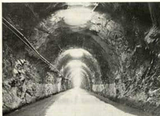
Adkomsttunnelen sett mot utgangen. Det er 1 200 m opp til åpningen og rett fin bilvei. Men det er bratt, stigningen er 1 : 7,5. Lysstyrken i tunnelen varierer mellom 3 og 8 Lux, og dette er fullt ut tilstrekkelig.
