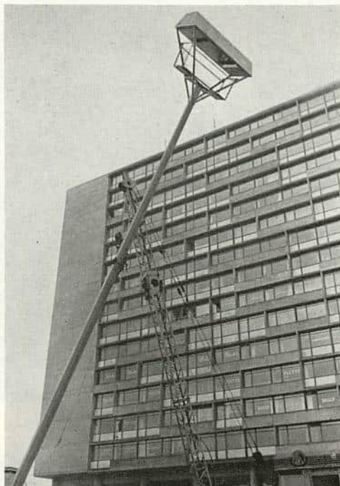
1,1 tonn veier armaturen som allerede ved reisingen er plassert på masten. Masten er 23 m over bakken.
