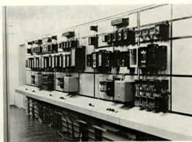
Generatorreléene er montert på relétabler av samme type som i sin tid ble brukt i Hjørdøla og senere i Lunset.
