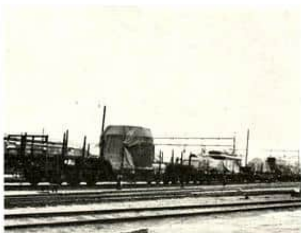
Til A/S Skafså Kraftverk i Telemark leverer vi i disse dager en generator på 21 000 kVA. Transporten gikk via Oslo og ovenfor sees 3 jernbanetogner med tilsammen 90 ton gods.
